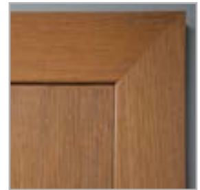
łączenie opasek pod kątem 45°
