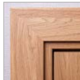
standardowe łączenie opasek pod kątem 45°
